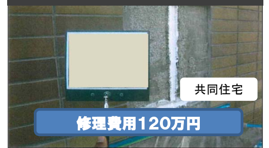
外壁タイル目地クラックから内部に雨水が浸入(築20年)
