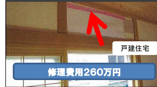
外壁(板金取合い部)からの雨漏り(築22年)
