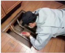
「土台・床組、基礎」調査の様子
