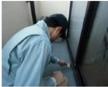
「外部(バルコニー)」調査の様子
