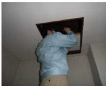
「小屋組・梁」調査の様子
