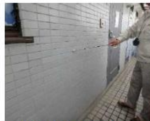
「外部(外壁)」調査の様子
