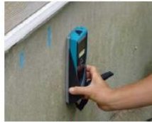
「基礎配筋」の調査機器
